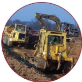
Formation initiale à la conduite d'engins de chantiers
